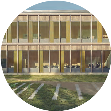
drugi fasadni sloj - kombinacija večjih steklenih površin in lesene prezračevane fasade
