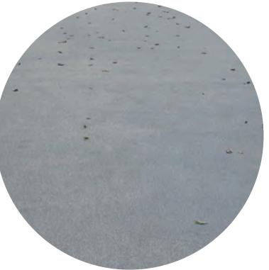
tlak zunanjih teras - EPDM guma v granulatu
