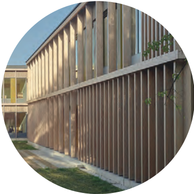
prvi fasadni sloj - lesene vertikalne lamelle pravokotnega profila na različnem rastru
